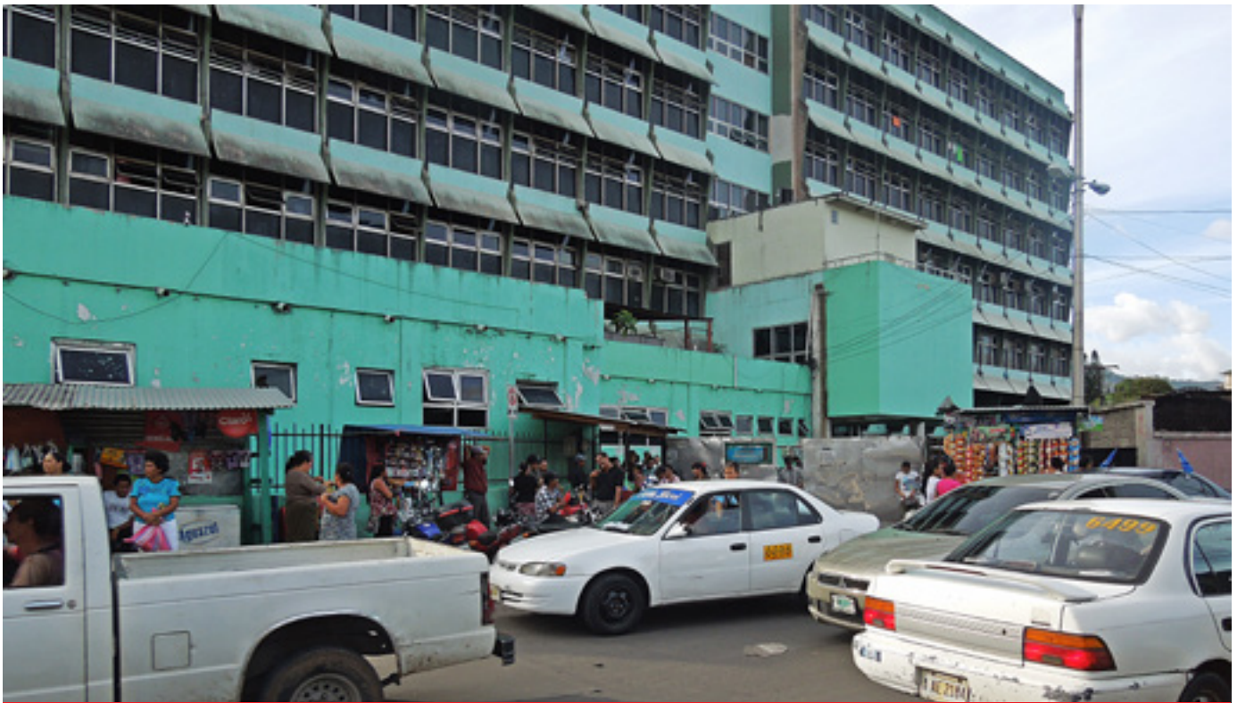
Uno de los laterales del gran Hospital Escuela que hoy ha mejorado substancialmente.
