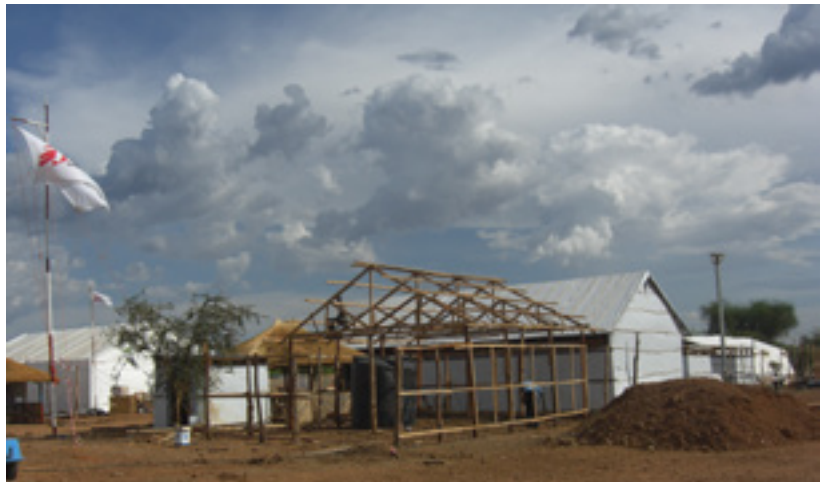
La nueva red de tuberías también dota de agua a un hospital operado por MSF.
