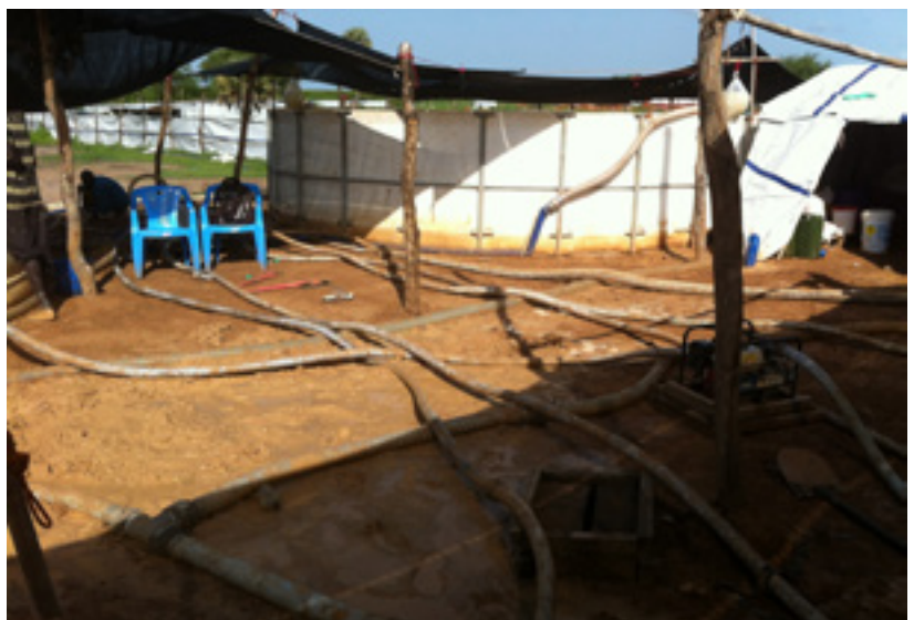
La falta de materiales retrasaba con frecuencia el trabajo.
